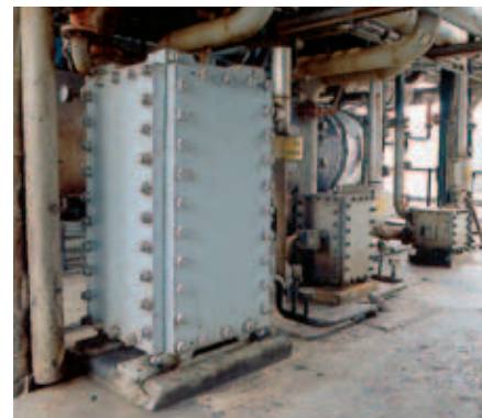
Obr. 5 – Tři jednotky Compabloc® pro chlazení petroleje a plynového oleje za atmosférického tlaku na destilační věži v Nynas Petroleum, Švédsko
