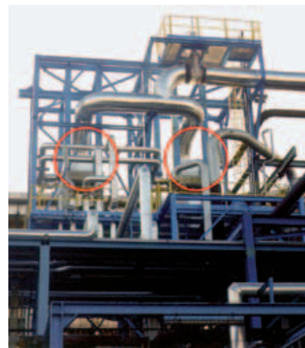
Obr. 3 – Dva z celkového počtu čtyř horizontálně instalovaných výměníků Compabloc® s titanovými deskami na kondenzaci par v destilační věži rafinerie Tamoil ve švýcarském Collombey
