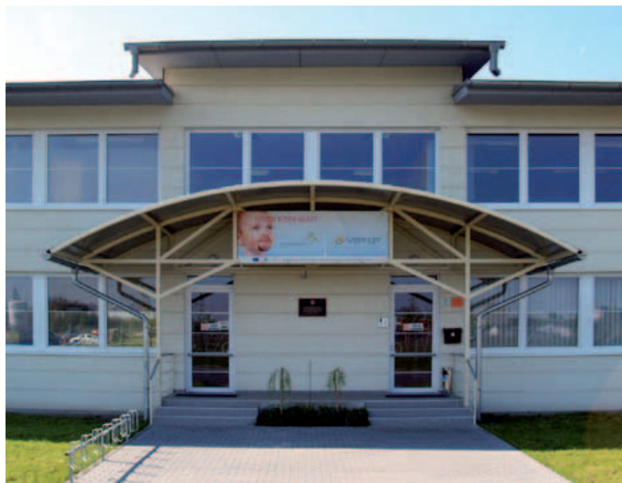
Obr. – Budova Vědeckotechnického parku Univerzity Palackého v Olomouci
