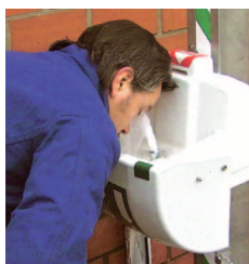
Obr. 1 – Samostatně stojící oční sprcha, průmyslové provedení s krytem, nerez
