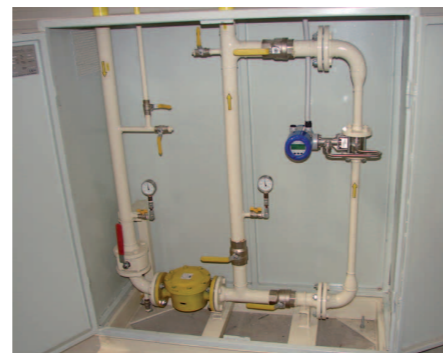
Obr. 4 – OPTISWIRL 4070 C DN50 s integrovanou teplotní a tlakovou kompenzací měří průtok zemního plynu
