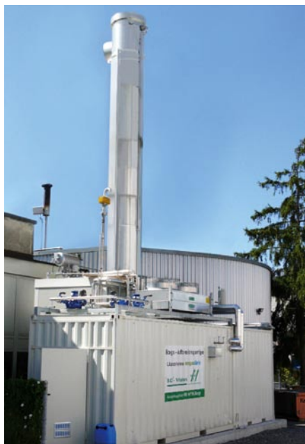
Obr. 3 – Čistící stanice bioplynu Meilen-Herrliberg-Uetikon
